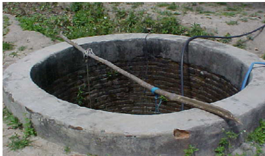
Figura 37: Poço à margem do rio Acaraú. Os poços profundos ou artesanais (cacimbões) correspondem a uma estrutura hidráulica, com um perfil verticalizado e em forma de tubo – tubular. Servem para captação de água subterrânea diretamente do aquífero.
