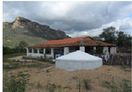
Figura 39: cisterna de placas
