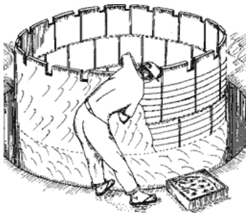
Figura 38: Construção de cisternas
