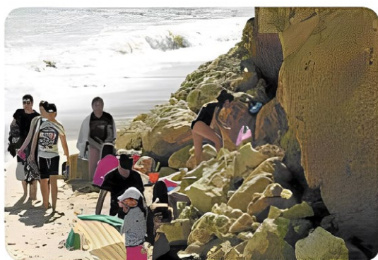
[Fig. 10] Derrocada no Algarve.
