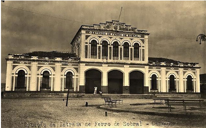
Estação Ferroviária de Camocim. Primeiras décadas do séc. XX.
