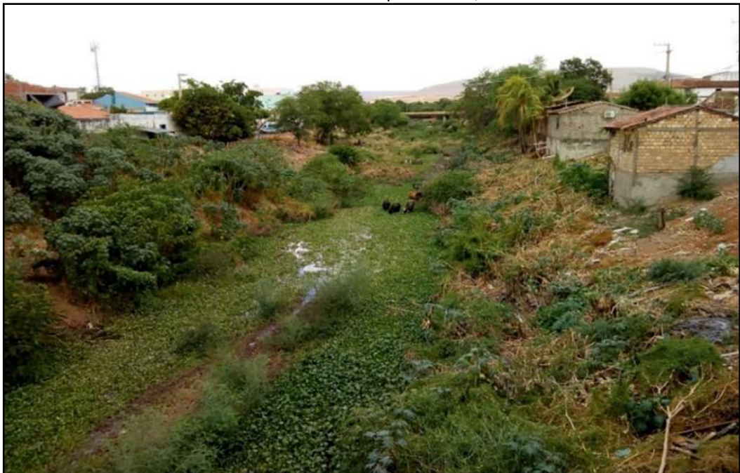
Figura 8 – Fotografia mostrando ocupação inadequada das margens do rio Guaribas na zona urbana do município de Picos, Piauí
