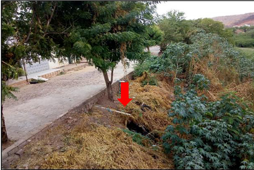
Figura 9 – Fotografia que destaca lançamento de efluentes no rio Guaribas na zona urbana do município de Picos, Piauí
