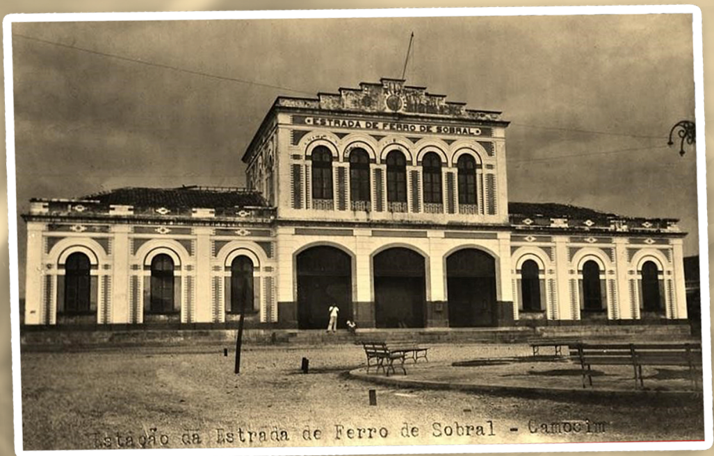
Figura 1 - Estação Ferroviária de Camocim. s/d.
