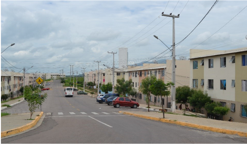
Figura 53 - Residencial Nova Caiçara-Sobral-CE
