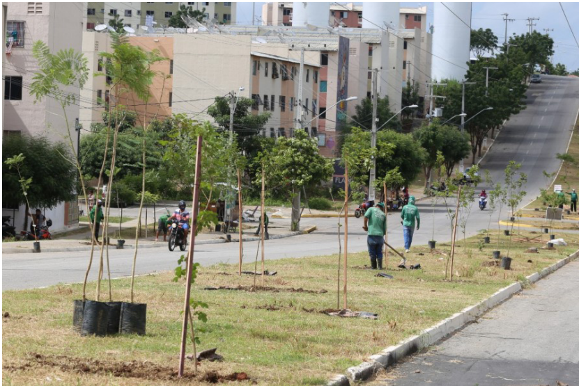
Figura 44 - Obras de implementação de corredor verde em via pública de Sobral-CE
