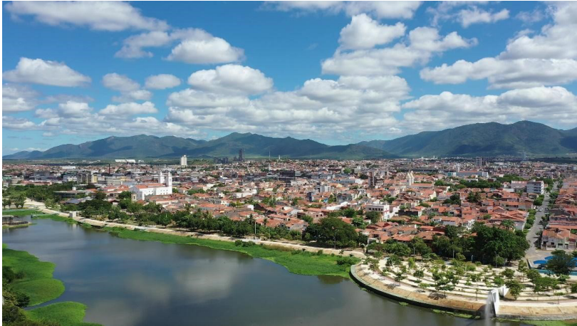
Figura 16 - Imagem da margem esquerda do rio Acaraú, feita com drone
