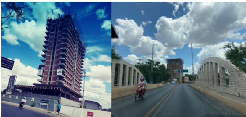
Figura 18 - Imagens de edifício vertical construído próximo ao North Shopping Sobral
