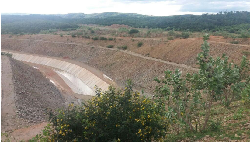
Figura 02 - Trecho do Cinturão das Águas do Ceará – CAC no Assentamento 10 de Abril
