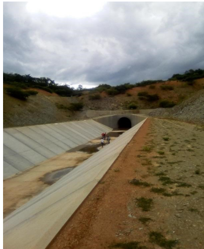
Figura 3 - Túnel do canal que passa pelo assentamento
