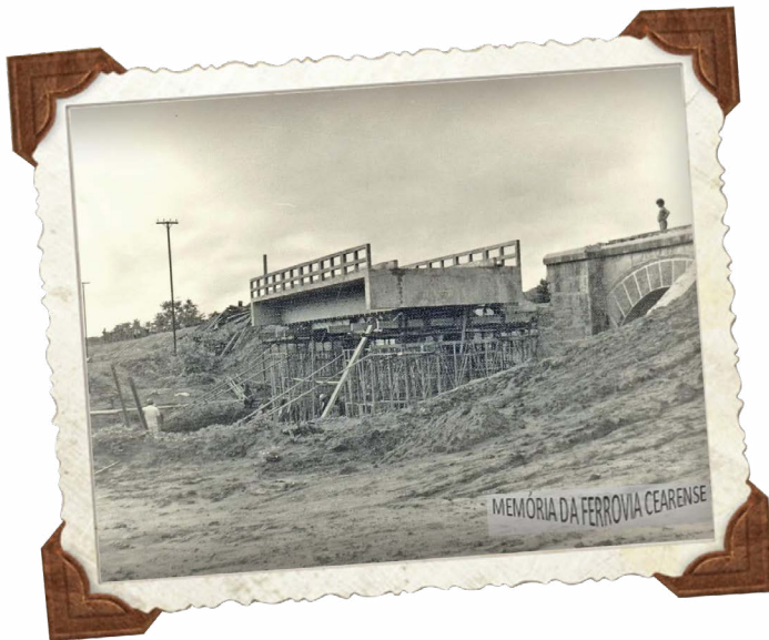
Figura 28 - substituição de pontilhão metálico por estrutura fixa em concreto no quilômetro 355 (entre Fortaleza e Ipueiras), janeiro de 1985
