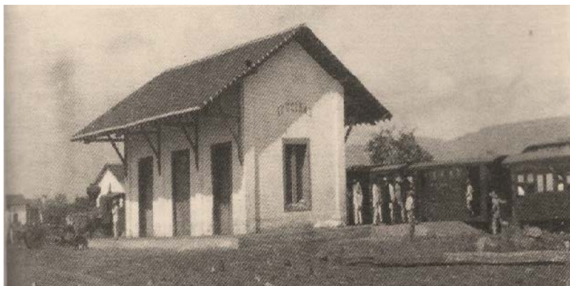
Figura 3 - Estação de Ipueiras-CE. Início séc. XX
