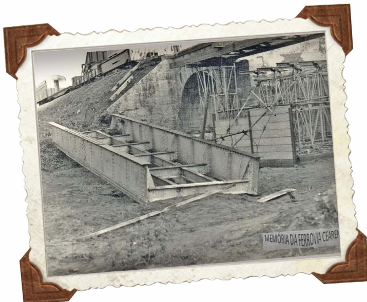
Figura 26 - substituição de pontilhão metálico por estrutura fixa em concreto no quilômetro 355 (entre Fortaleza e Ipueiras), janeiro de 1985
