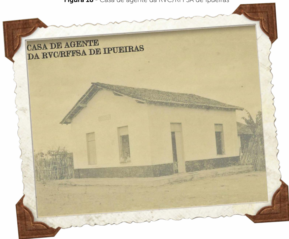
Figura 18 - Casa de agente da RVC/RFFSA de Ipueiras
