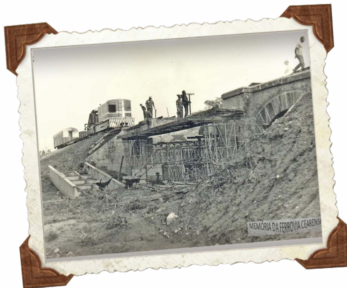
Figura 25 - substituição de pontilhão metálico por estrutura fixa em concreto no quilômetro 355 (entre Fortaleza e Ipueiras), janeiro de 1985
