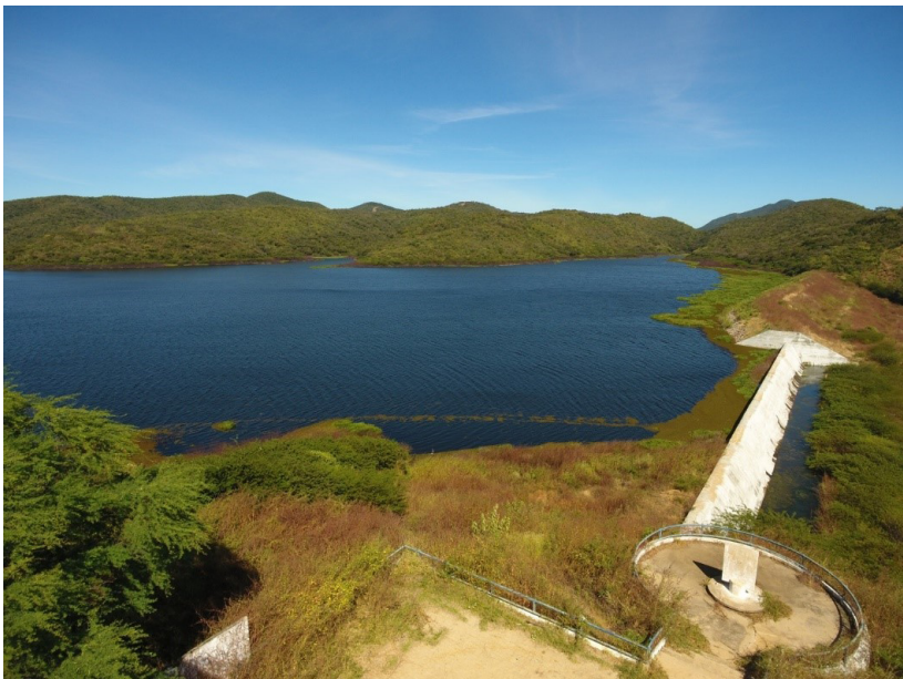
Figura 14 - Barragem de Capoeira, localizada no município de Santa Terezinha/PB
