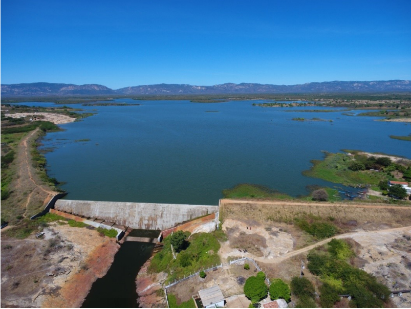
Figura 13 - Barragem da Farinha, maior reservatório de água do município de Patos/PB
